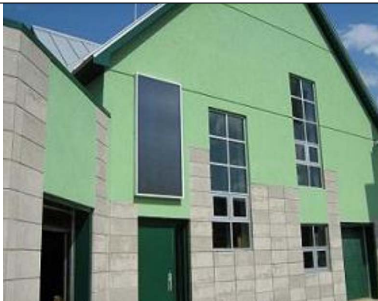
ESOLAIR 2.0 au Centre d'interprétation d'énergies renouvelables Richelieu, Qc
